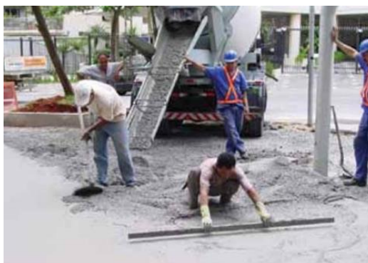
Figura 8 – Recebimento e espalhamento do concreto
