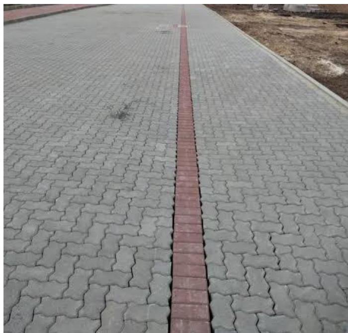
Figura 5 – Referência da colocação do bloco retangular vermelho e o unistein
